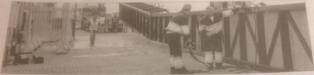
Un grupo de operarios tras rescatar ayer de las aguas la pasarela de la prolongación con duques de alba del atraque de cruceros. // R. Grobas
